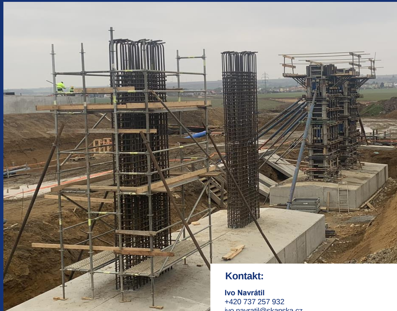
Bednění spodní stavby
